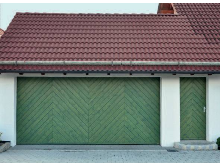
Kipptor mit ansichtsgleicher Garagennebentüre
