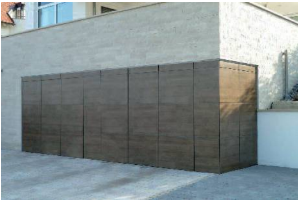
Tor- und Eckverkleidung mit Fassadenplatten
