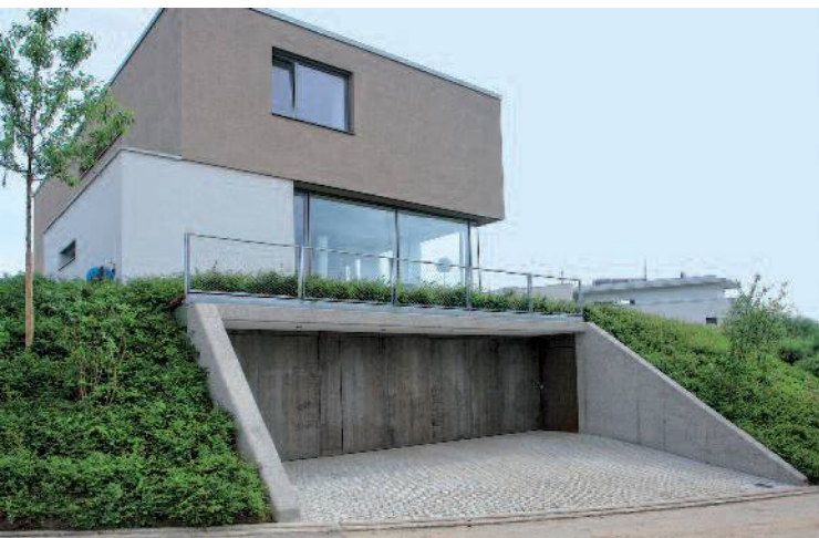
Kipptor bauseitig mit Cortenstahl verkleidet
