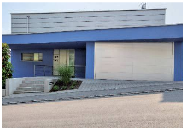
Torverkleidung aus Aluminium-Platten
