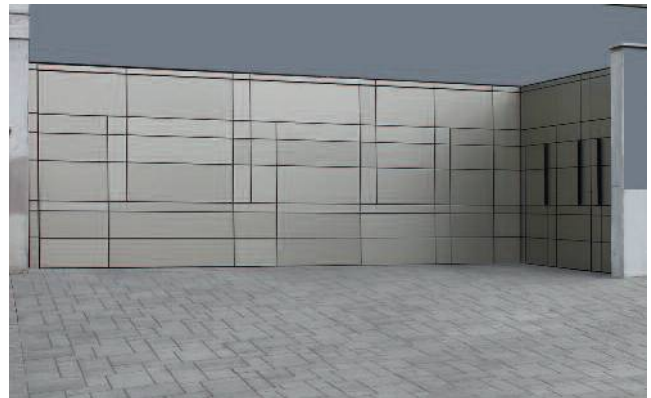
Tor- und Wandverkleidung mit Aluminiumplatten
