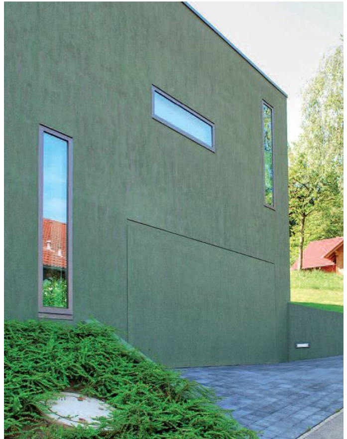
Das Tor wurde in den Vollwärmeschutz integriert und bauseitig mit Edelputz überzogen
