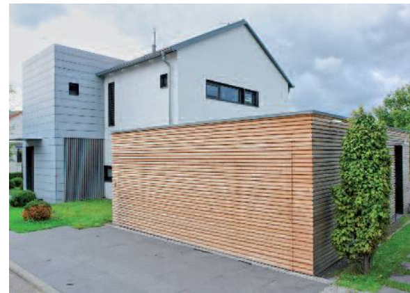
Flächenbündiges Kipptor mit Profil-Schalung aus Lärchenholz
