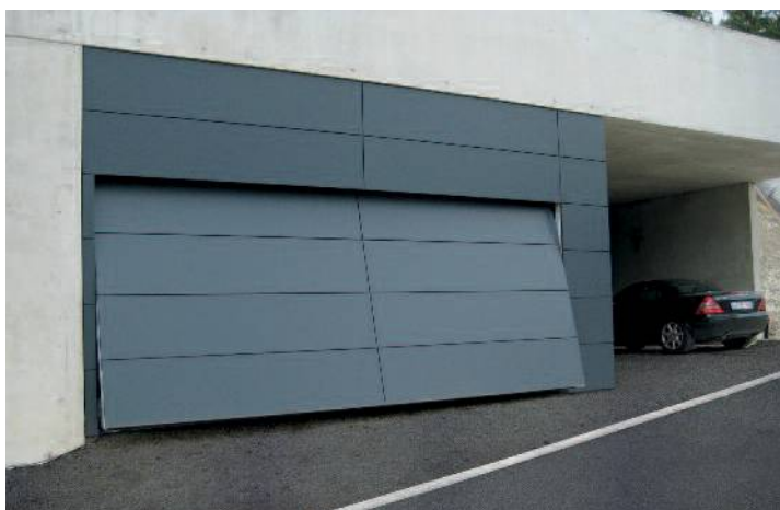
Flächenbündiges Tor bauseitig mit Fassadenplatten belegt
